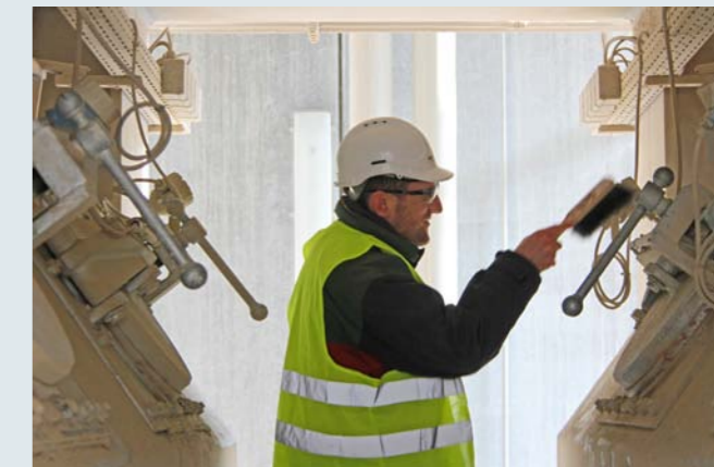
13:30 Uhr: Nicolas Bächle fegt den feinen Kalkstaub von den Temperaturmessfühlern zwischen den Ofenkammern weg
