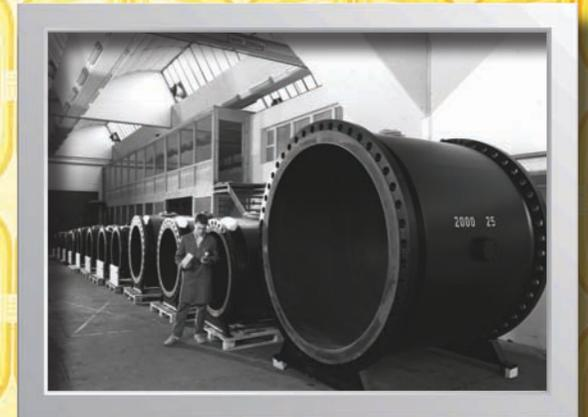
**1978** Rohre für Durchflussmessgeräte mit großer Nennweite.
